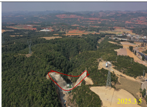
在建小板田水库
