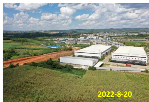
项目区东面（云南冠益管道有限公司）
